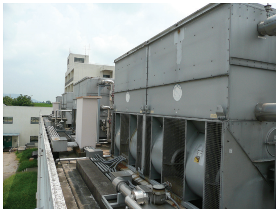
図 2-90 電源棟の冷却塔
