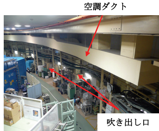
(b) リングトンネル内の空調
