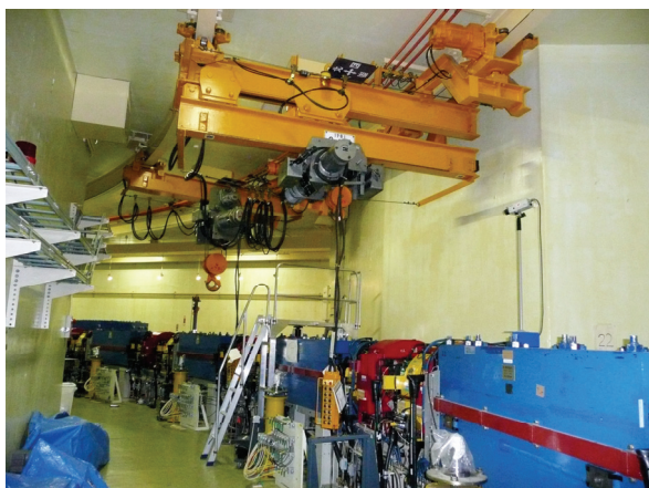
図 2-97 リングトンネル内のクレーン
