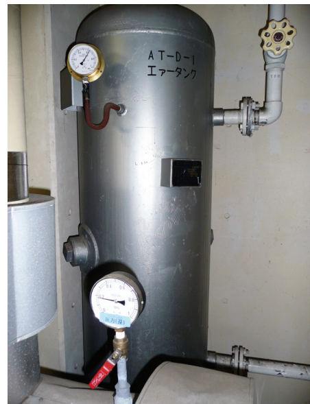
図 2-93 エアータンク
