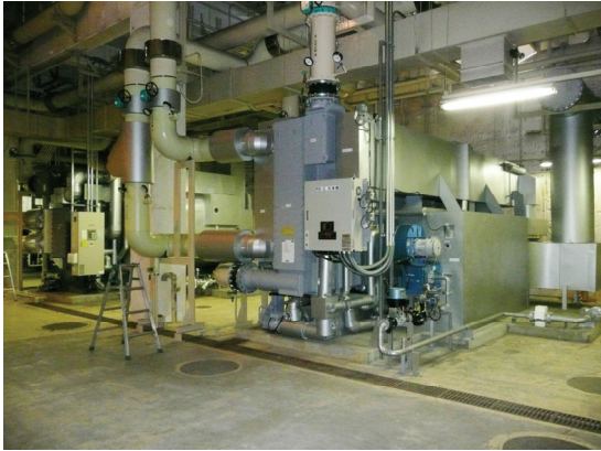
図 2-88 エネセンの冷凍機
