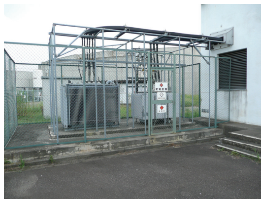
図 2-85 PF 電源棟の変電設備
