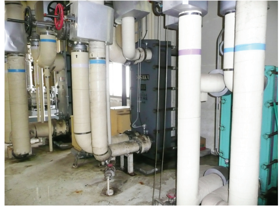
図 2-91 電源棟の熱交換機
